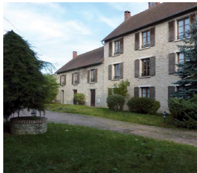
> 22 logements à Pussay.
